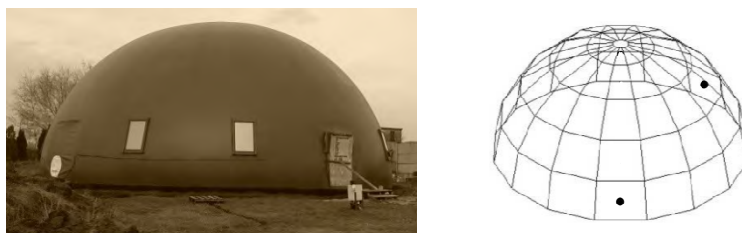
Rys. 16. Widok badanego obiektu oraz uproszczony model geometryczny z punktami pomiarowymi
