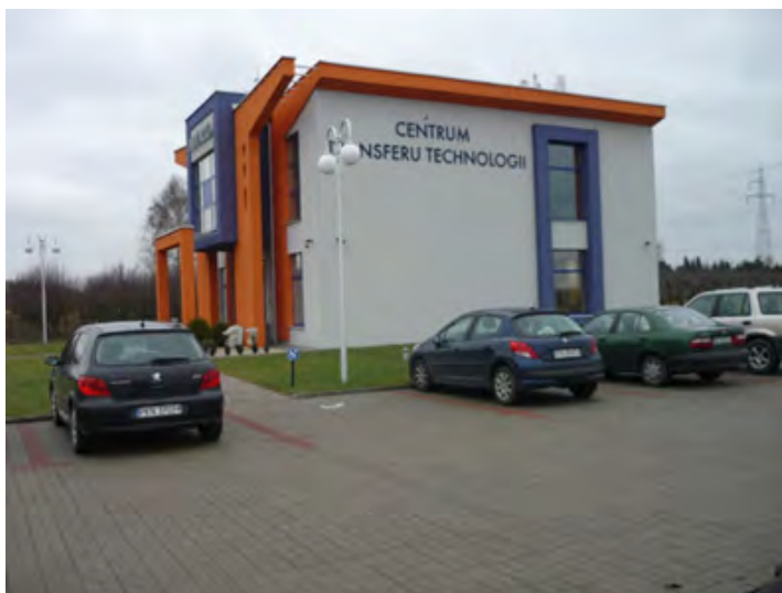
Rys. 4. Budynek oceniany pod kątem certyfikacji BREEAM
