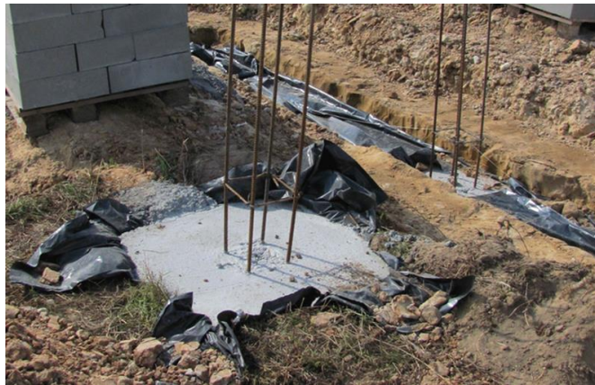
Rys. 5. Wypuszczone zbrojenie pod słup żelbetowy monolityczny ze stopy fundamentowej [4]
