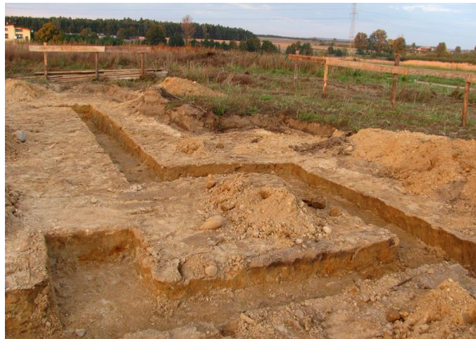
Rys. 3. Przygotowanie wykopów pod łąwy fundamentowe [4]
