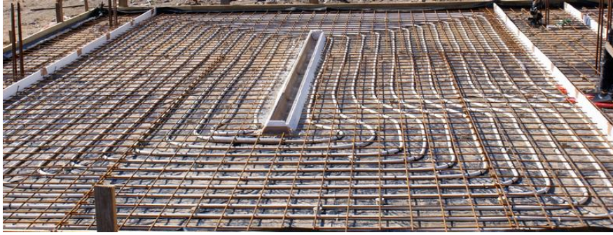
Rys. 6. Ułożone zbrojenie płyty fundamentowej wraz z instalacją ogrzewania podłogowego [4]
