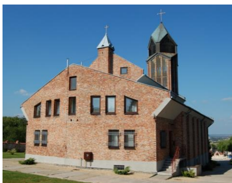
Fot. 6. Elewacja tylna kościoła pw. św. Anny w Myszkowie
