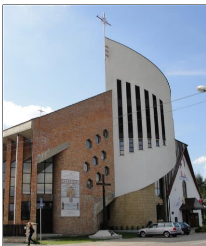
Fot. 9. Elewacja frontowa kościoła pw. św. Apostołów Piotra i Pawła w Myszkowie
