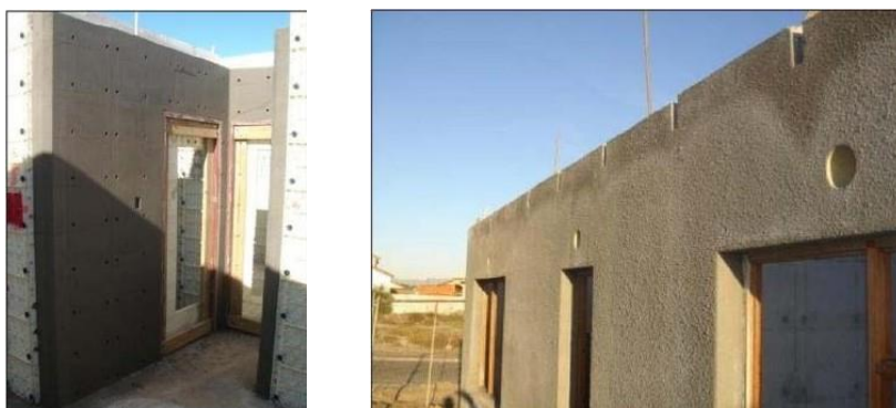
Rys. 5, 6. Widok ścian zewnętrznych budynku z pianobetonu
