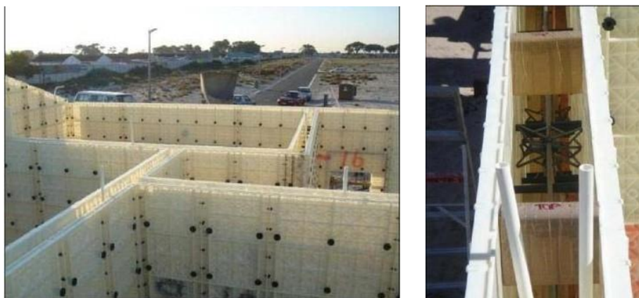
Rys. 3, 4. Szalunki ścian budynku jednokondygnacyjnego
