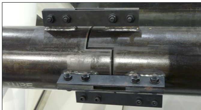
Rys. 4b. Styk rury - etap montażowy (fotografia autora)
