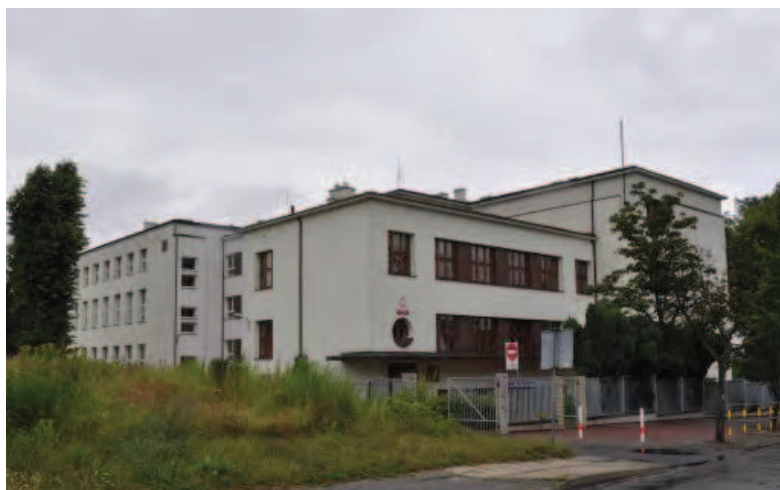
Rys. 4. Szkoła przy ulicy Sikorskiego - widok na wejście główne (fot. autorki)
