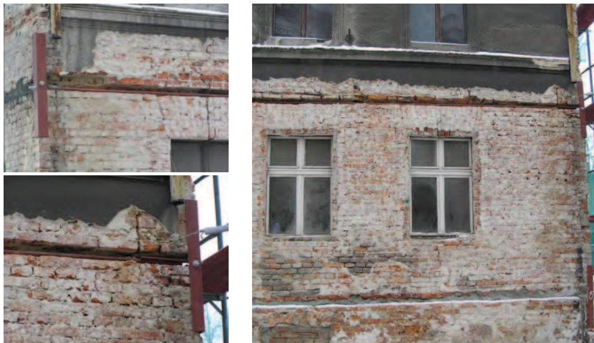
Rys. 1. Wzmocnienie budynku w poziomie stropów międzykondygnacyjnych
