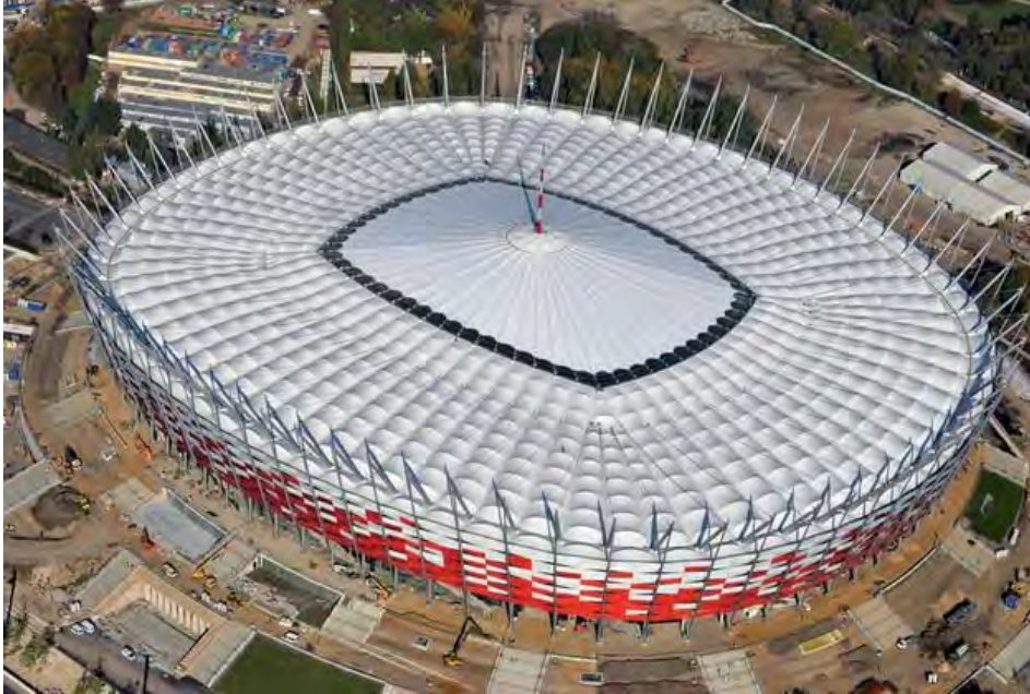
Rys. 5. Widok na dach Stadionu Narodowego w Warszawie [13]
