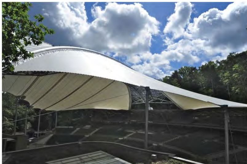
Rys. 3. Widok dachu Opery Leśnej w Sopocie [11]
